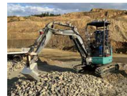
Fig. 5 Blasted-rock excavation by mini excavator
