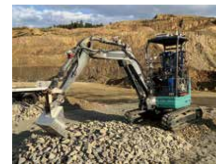
Fig. 5 Blasted-rock excavation by mini excavator
