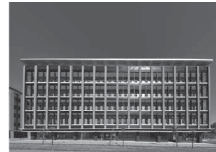
竣工した本館外観
