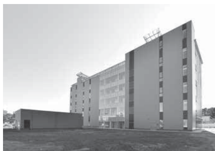
本館北面 屋上に自然換気のためのチムニーシャフト
