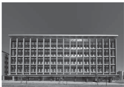
竣工した本館外観
