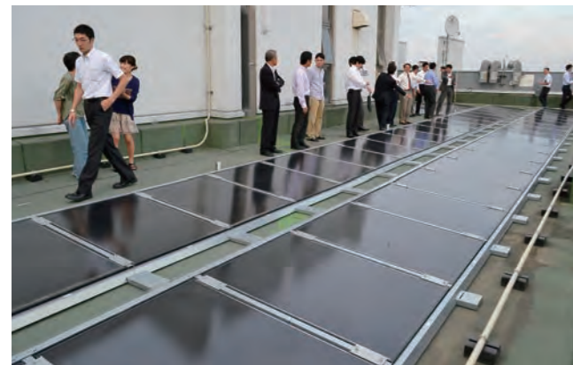
Fig.1 設備説明会の様子
