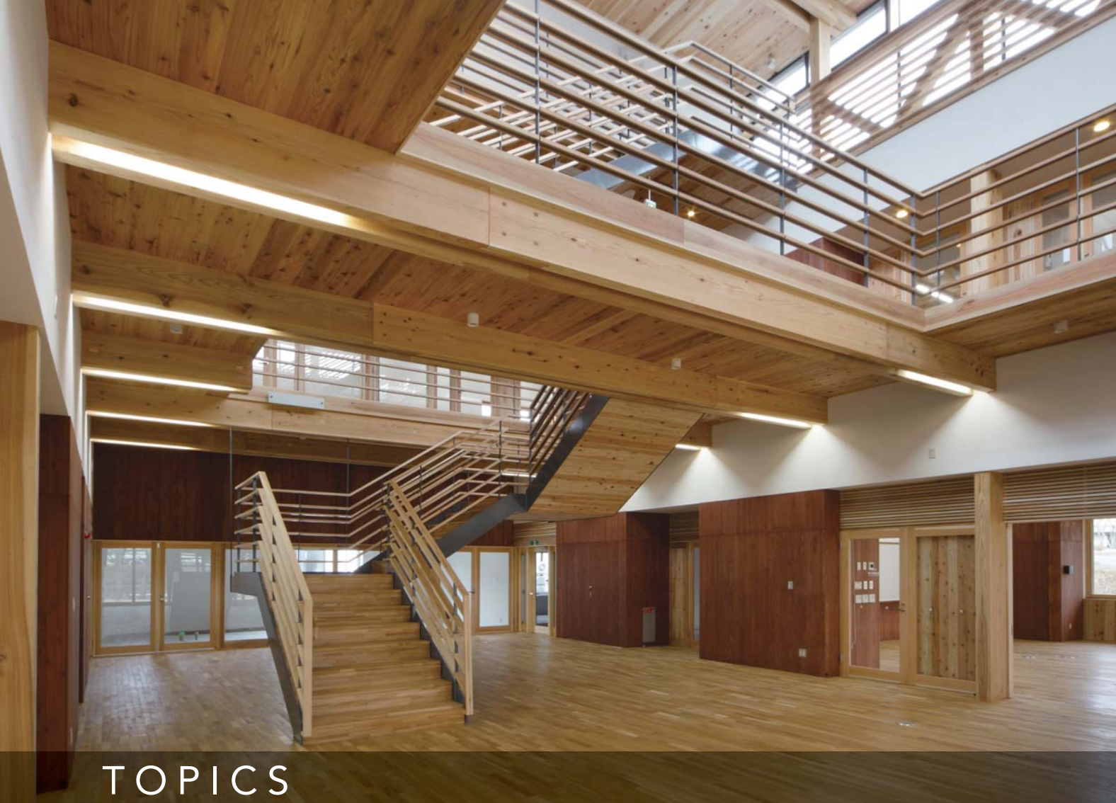
fig.1 竣工を迎えた「エコラボ」内部
