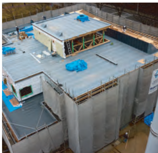
Fig.2 建設の進むエコハウス
