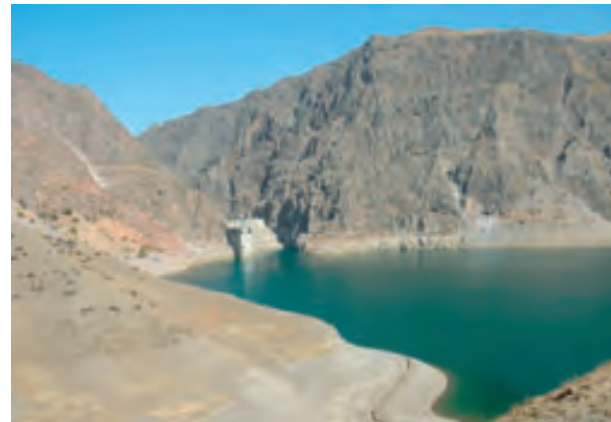
キルギス共和国の雪解け水による山岳の貯水ダム。水門からパイプでウズベキスタンのフェルガナ盆地へ流水される。
