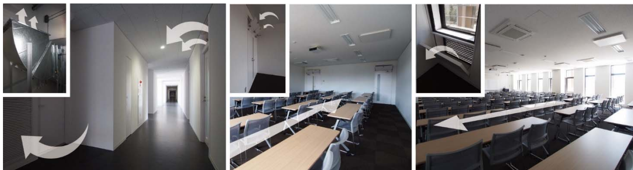
図VI-4 自然通風経路：廊下～シャフト（左下）居室～廊下（中央下）南側窓～居室（右下）
