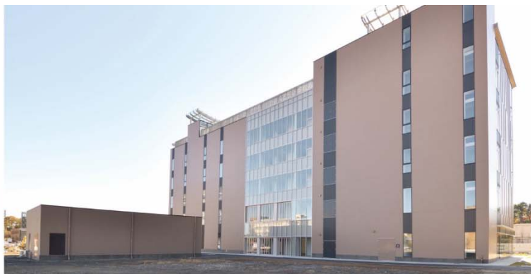
図VI-7 新棟配置図:研究室棟から独立した電気室 (左) 新棟北面:平屋独立建物/電気室 (右)
