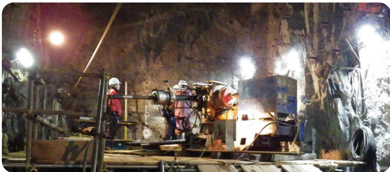
図1 釜石鉱山の地下約300m地点での地殻応力測定風景
