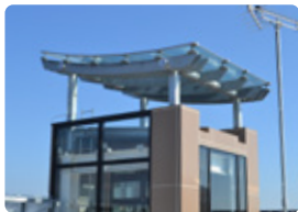
屋上にあるソーラーチムニーの設備 (ガラス張りので効率よく空気を温める)
