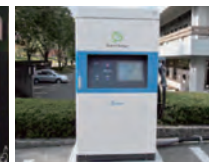
EV用急速充電器
