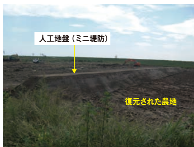
写真-2 施工後の現場の様子(仙台市若林区藤塚)
