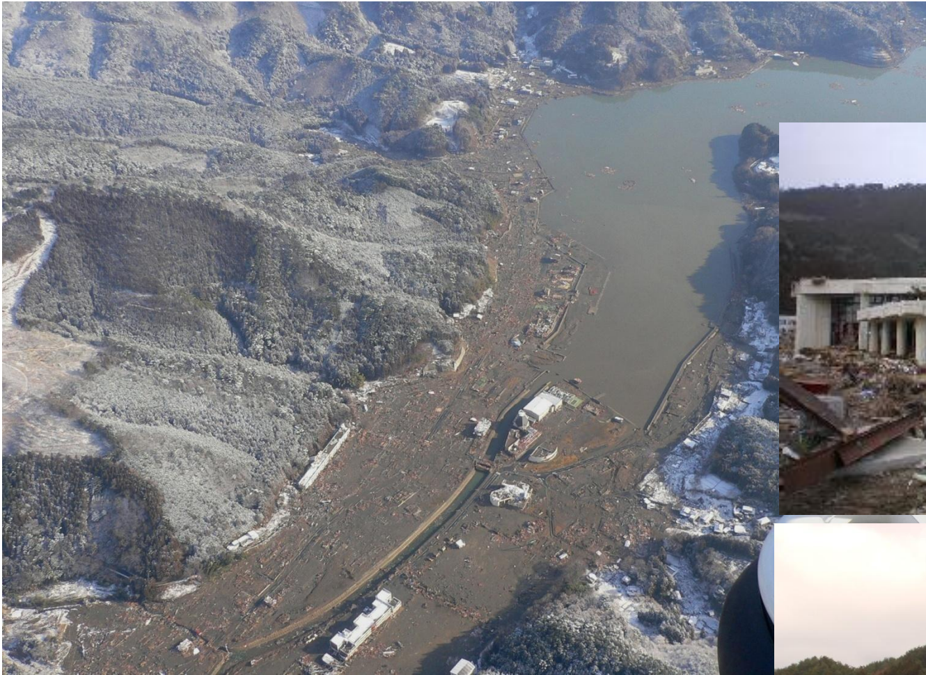
▲上空からの雄勝地区の被災状況 (3月12日 国交省ヘリ撮影)
