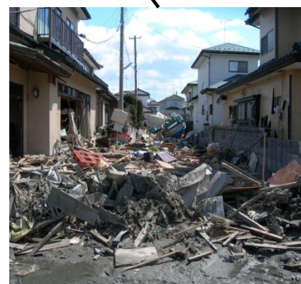
住宅地の被災(3月28日撮影)
