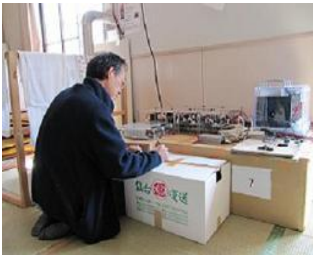
石巻市北上町十三浜大指地区に充放電システムを設置する田路教授
